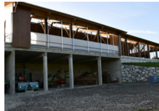
Unter dem, am Hang gebauten Stall, wurde (teilweise) eine Maschinenhalle integriert, wobei die nördlichen Öffnungen vor dem Winter noch mit Rolltoren ausgestattet werden sollen.
